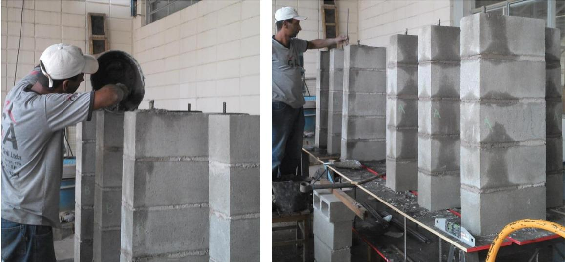
Figura 5.9 – Grauteamento e adensamento do graute nos prismas
