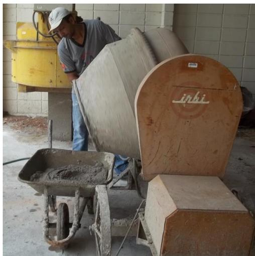
Figura 3.26 – Confecção da argamassa de forma mecânica
